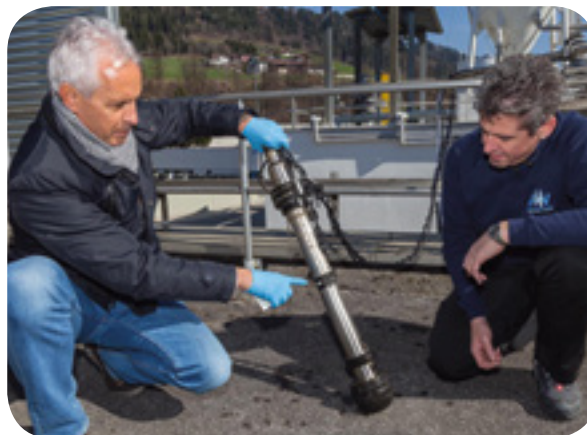
Peter Held und Manfred Anfang überprüfen die WTW-Geräte auf der Kläranlage Fritzens
